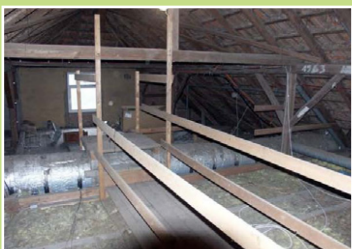
Sanierung des Dachbodens
