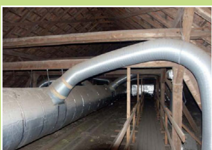
Sanierung des Dachbodens
