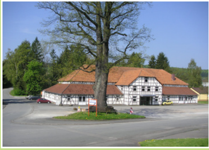
1. BAUABSCHNITT Rückbau der Anbauten und Sanierung des Küchentrakts
