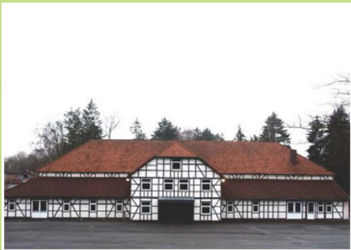
2. BAUABSCHNITT Sanierung des historischen Hallenteils
