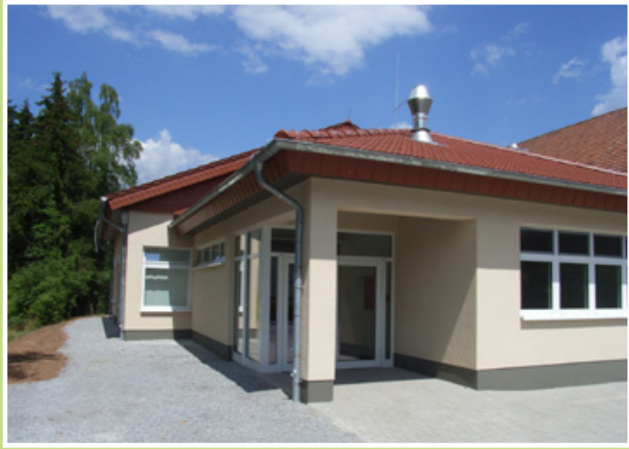
Neuer Anbau durch Dipl.-Ing. Architekt Friedbert Lamotte
