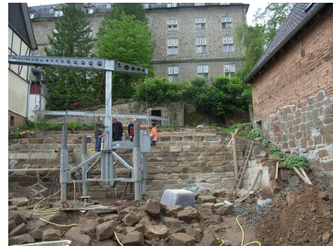
Baustelle Lange Straße 21
